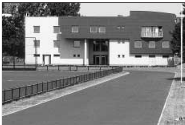
Nowy stadion oraz budynek rektoratu AWF w Poznaniu
